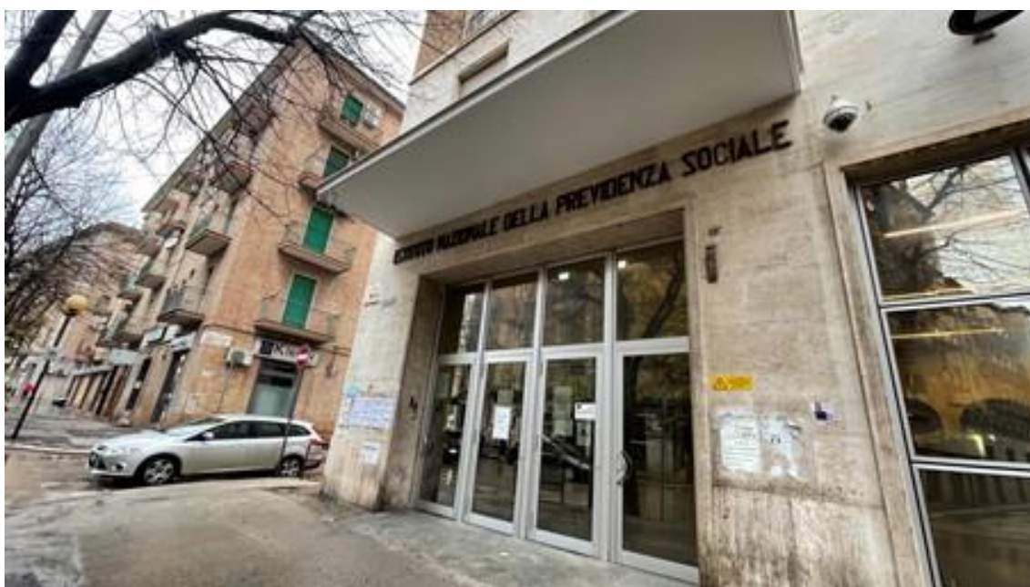
La sede Inps di Foggia*
